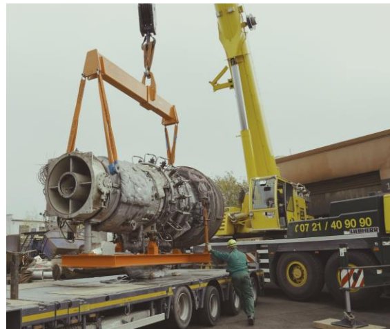
Abbildung 2: Anlieferung der Gasturbine in Karlsruhe
